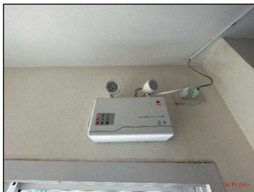
รูปที่ 2-28 ติดตั้ง Emergency Light
