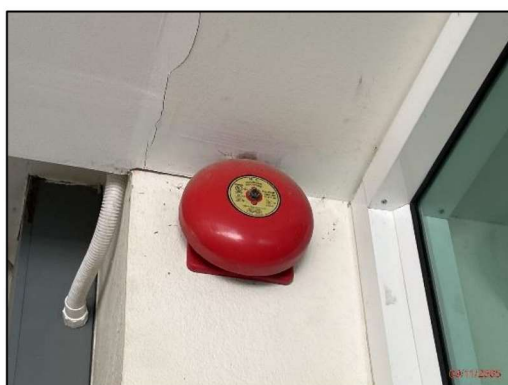
รูปที่ 2-30 กริ่งสัญญาณเตือนอัคคีภัย
