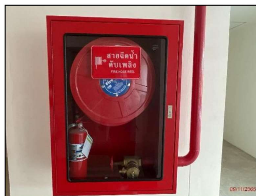
รูปที่ 2-27 ตู้เก็บสายฉีดน้ำดับเพลิงพร้อมอุปกรณ์
