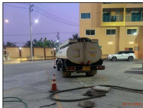
รูปที่ 2-11 ผู้รับเหมามาสูบกากตะกอนออกจากบ่อ เมื่อบ่อเกรอะเต็ม
