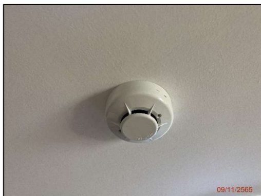
รูปที่ 2-29 เครื่องตรวจจับควัน
