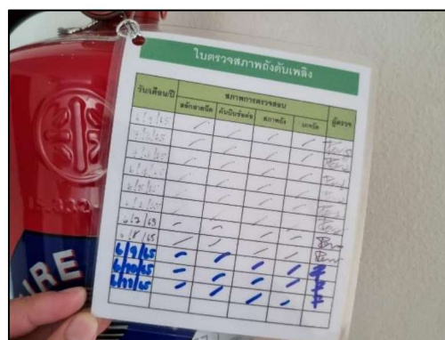
รูปที่ 2-25 ตรวจสอบระบบป้องกันอัคคีภัย
